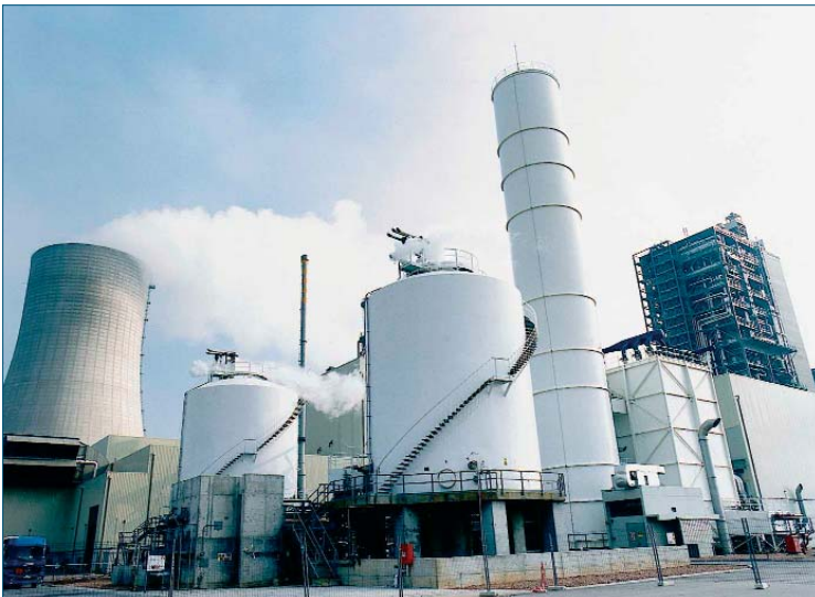
Figura 35: Unidad de Fraccionamiento de Aire.
